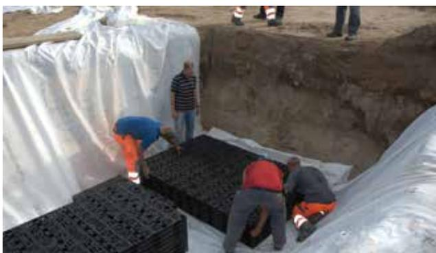
Para la infiltración de las aguas pluviales depuradas, se montaron elementos de infiltración DRAINFIX BLOC.
