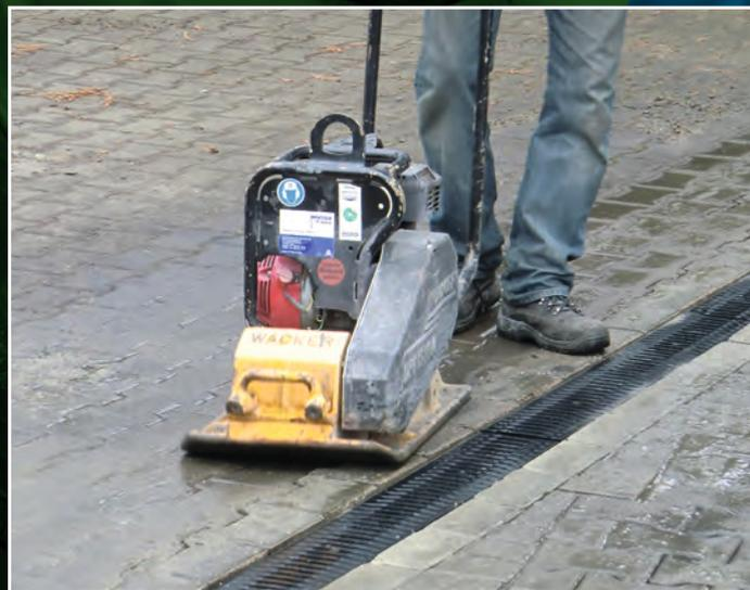
La elasticidad es importante al colocar por vibración el adoquinado a lo largo del canal **RECYFIX®**.
