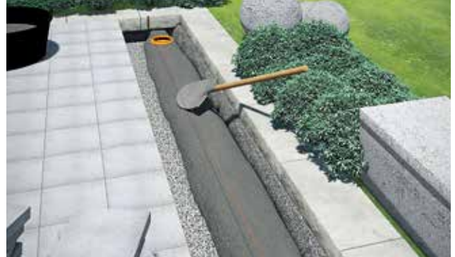
Paruoškite betono pagrindą.
