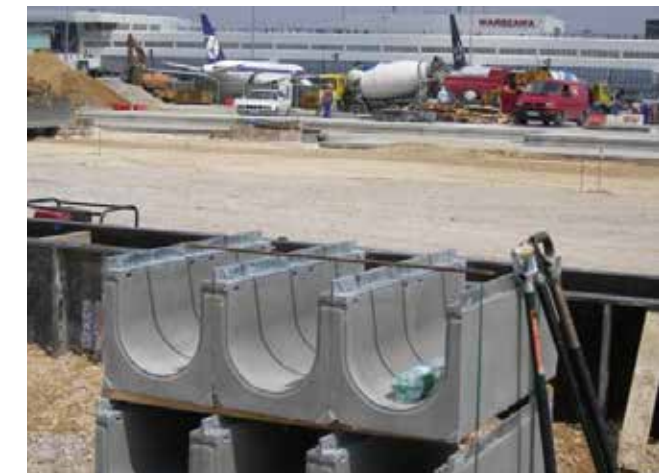
Oro uostas, Varšuva, Lenkija Įrengti FASERFIX®SUPER latakai
