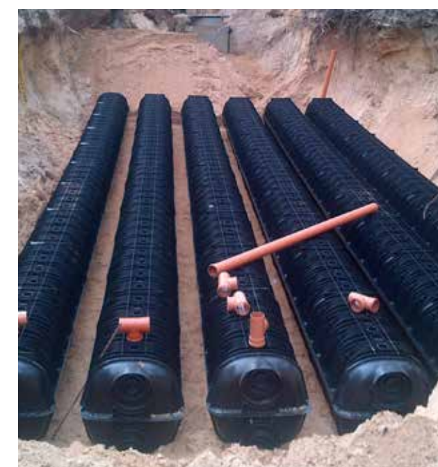
T. Kosciuškos g., Druskininkai, Lietuva Įrengti DRAINFIX®TWIN infiltraciniai elementai
