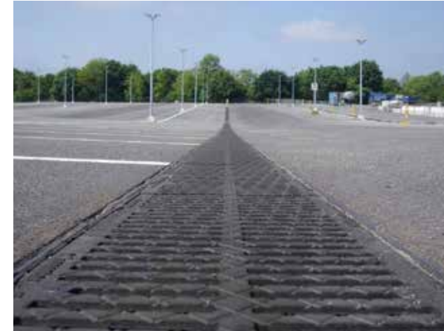
Aikštelė, Wolfsburgas, Vokietija Įrengti RECYFIX®PLUS X latakai
