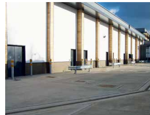
Montavimas betono dangoje
