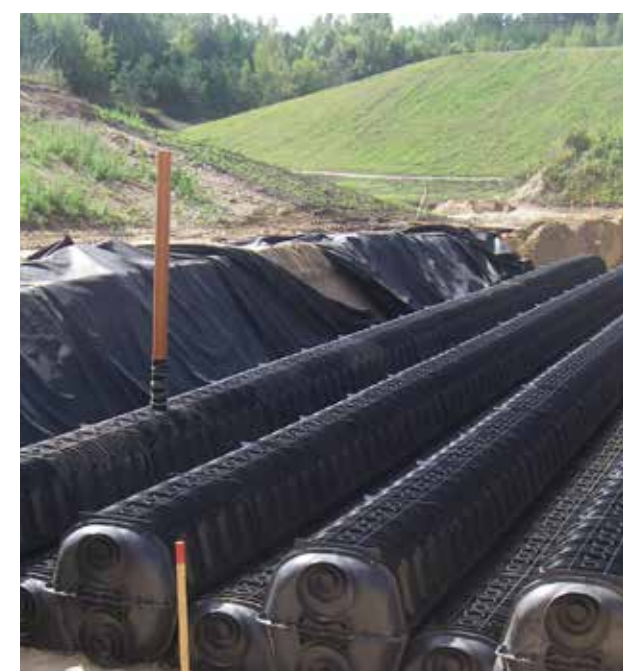
Didelių gabaritų atliekų surinkimo aikštelė, Švenčionėliai, Lietuva Įrengti DRAINFIX®TWIN infiltraciniai elementai
