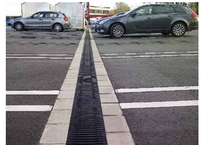
Aikštelė, Vokietija Įrengti RECYFIX®MONOTEC latakai
