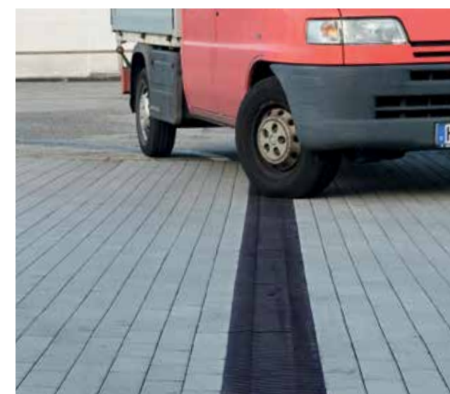
Montavimas trinkelio dangoje
